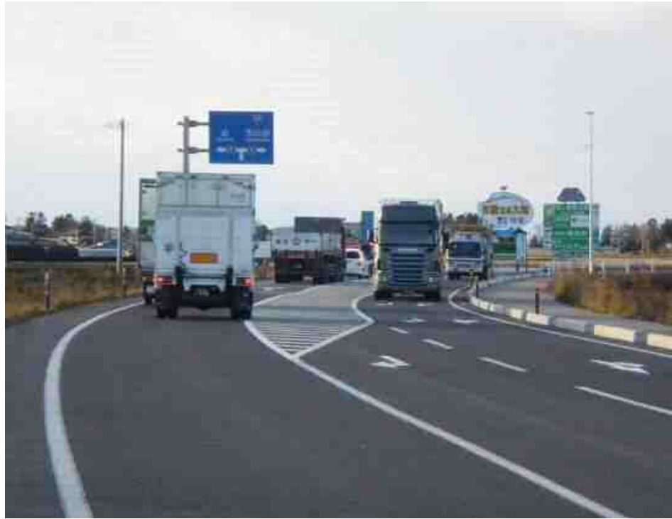
平成21年2月に供用開始した登米インターチェンジとⅡ期（中田工区）接続部
