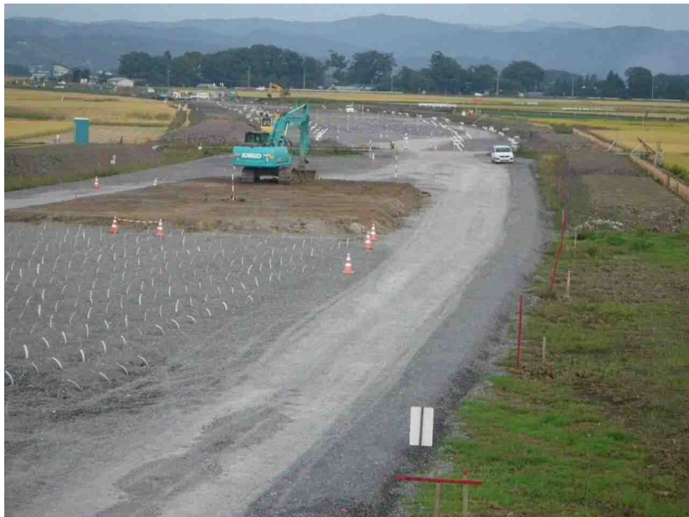
プラスチックボードドレーン施工状況（終点方向）
