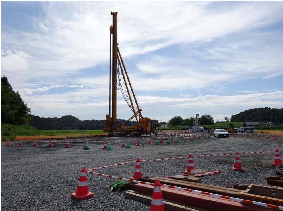
Ⅳ期終点部 軟弱地盤対策工施工状況
