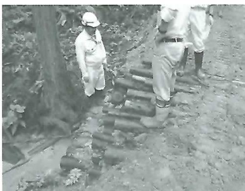
丸太組工法(洗い越し)について確認
