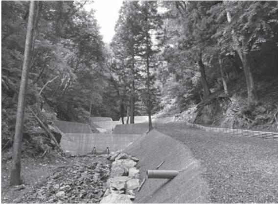
渓流の安定を図る治山ダム
