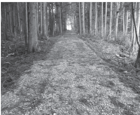
【南三陸町並石線】復旧状況写真
