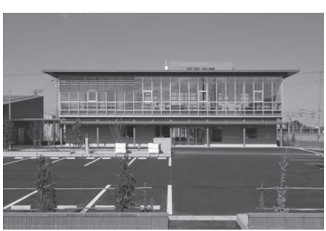
県産CLT等を使用し、『ZEB』を取得した社屋
