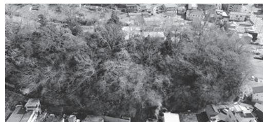
施工前の 山腹斜面
