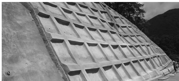
令和6年度法面改良工事 施工延長 L = 77.9m
