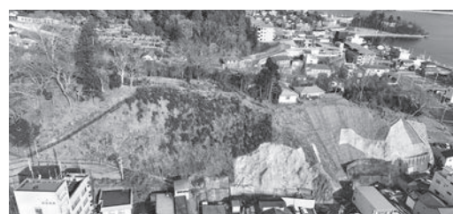
施工後の 状況
