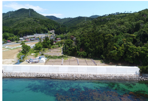
写真－7 復旧した防潮堤（石巻市十八成浜）
