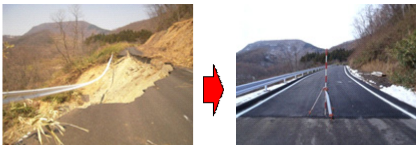
写真-5 復旧した林道（大和町高倉線）
