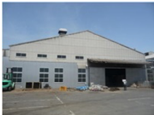
写真－8 復旧した合板工場（石巻市）
