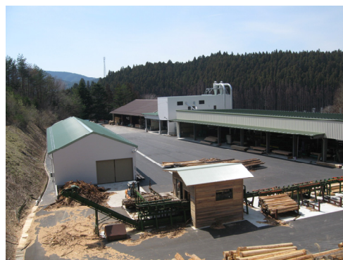
写真－9 復旧した製材工場（南三陸町）
