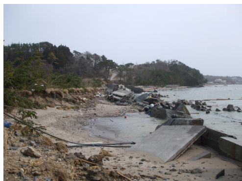
写真-3 海岸防潮堤の被害
