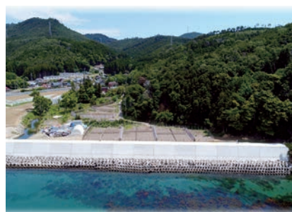
復旧した防潮堤
