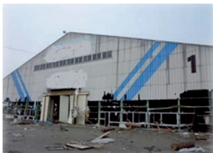
被災した木材加工施設
