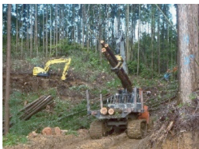
一貫作業現場の状況
