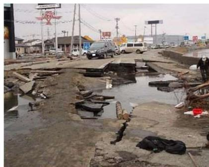
図 3-11 東日本大震災時の国道 45 号被災状況
