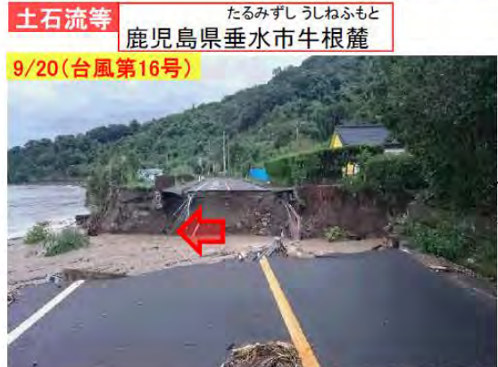
国道220号橋梁(磯脇橋)流失 【台風第16号経路】
