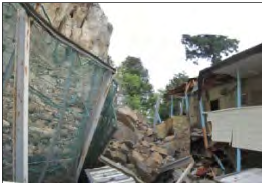
東北地方太平洋沖地震により発生したかけ崩れ (石巻市鹿妻 地内)
