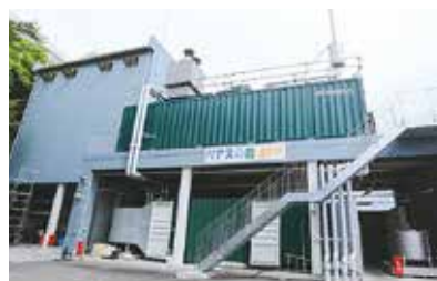
ガス化プラント
