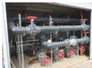
地下水をくみ上げるポンプ室 取水井と還元井は、 Φ150 100m×6本
