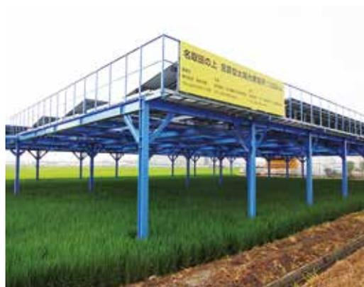
畑や田んぼで農作物を育てながら、作物の収穫量を下げずに太陽光発電をする、それがソーラーシェアリング(営農型太陽光発電)です。作物に一定以上光が当たってもそれ以上光合成しないため、その植物が使わない光をソーラーシェアリングで活用します。
