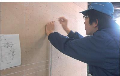
「がいし引き工事」の実技風景。建物に電線を引き込む際に使うもので、電気設備工事の基本技術の一つです。
