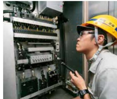
車両の様々な設備に電気を送る配電盤に異常がないか確認する
