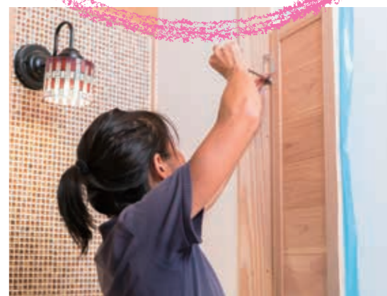
室内の扉や家具などの木工製品の製作や取り付けも大工職人が行うことがある
