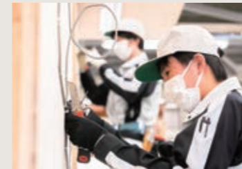
実習を通して電気配線の基礎を習得する
