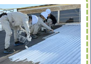
高等技術専門学校における職業訓練の様子（塗装施工科）
