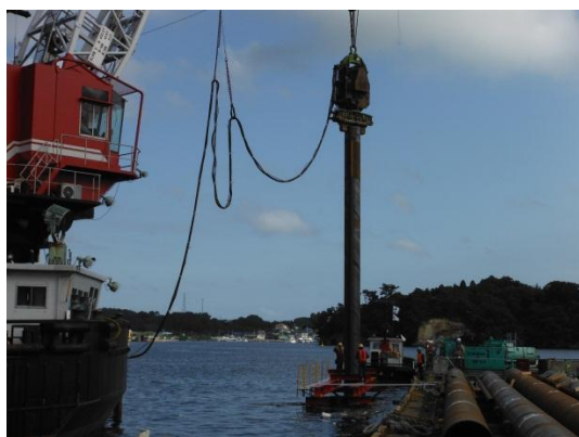
●貞山取付護岸工事の様子
