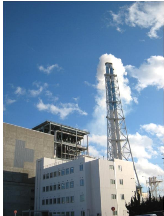
●新仙台火力発電所(東北電力株式会社提供)
