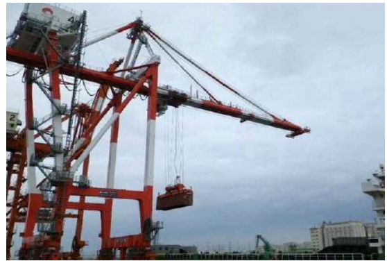
●稼働したガントリークレーン4号機
