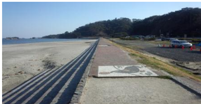
●施工を担当する松島港区浪打浜の様子
