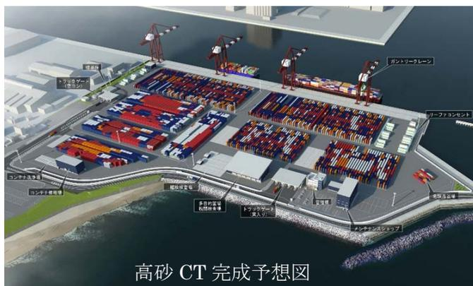
一方、コンテナ取扱量の増加に伴い、コンテナヤード内の狭隘化や、ゲート待ちのセミトレーラで臨港道路が渋滞するなどの問題も発生しております。これらに対応するため、現在高砂コンテナターミナルの拡張工事(約21ha→約27ha)を進めています。
