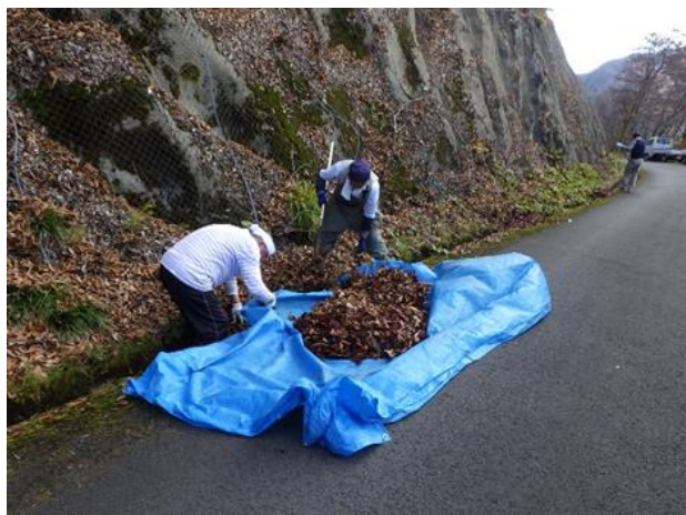
▲ 側溝の落ち葉等の撤去の様子
