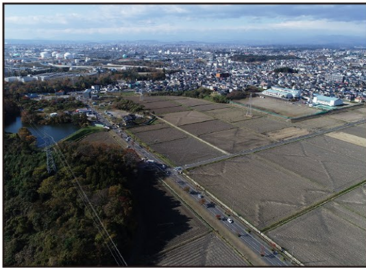
整備後の農地(七ヶ浜地区)
