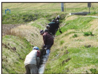
上竹谷農地・水保全管理協議会(松島町) ~共同活動による水路の土砂上げ
