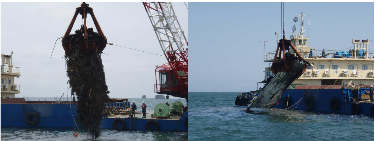
松島湾内の漁場の啓開作業（左：養殖施設等の塊 右：船舶）
