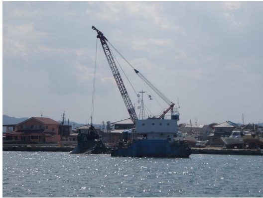
荒浜漁港内の啓開作業風景
