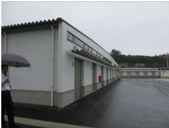
倉庫の全体風景
