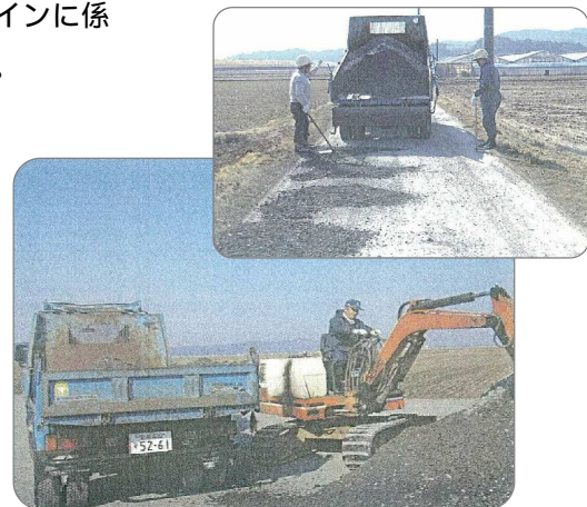
支線農道の維持補修(敷砂利補充)
