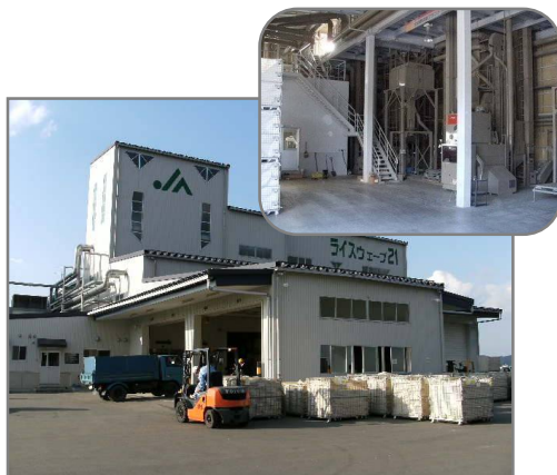
カントリーエレベーター
