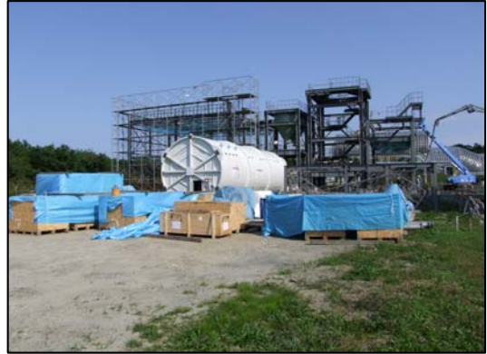
下水汚泥燃料化施設 建設状況
