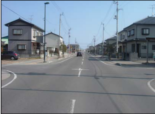
完成工区（Ⅰ期区間）の状況
