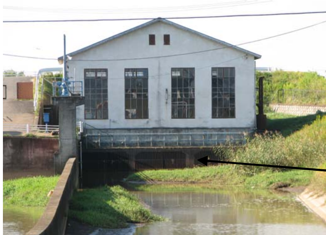
排水機場建屋の老朽化によるひび割れや吸水槽の亀裂が見られ、施設全体が劣化している。
