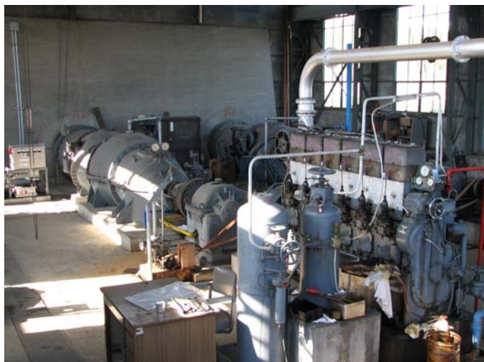
排水ポンプの老朽化が進行し、排水機能の低下が見られることから、施設を更新する必要がある。
