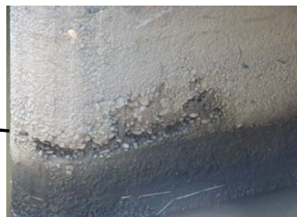
排水機場建屋の老朽化によるひび割れや吸水槽の亀裂が見られ、施設全体が劣化している。
