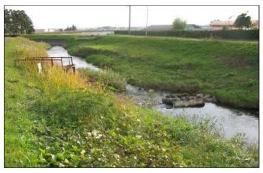
写真のとおり、地区内の取水堰は老朽化しており、かんがい排水事業の 導入により改修を行う必要がある。
