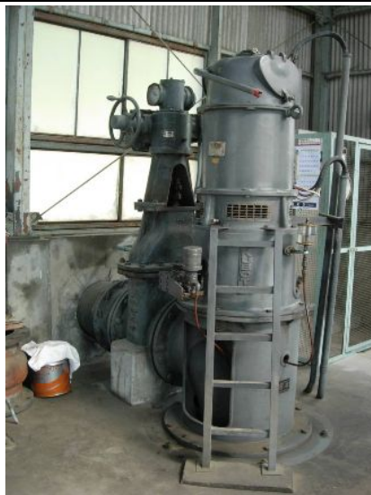
立軸斜流ポンプφ450は、造成から40年以上経過し、経年劣化による機能低下が懸念されている。
