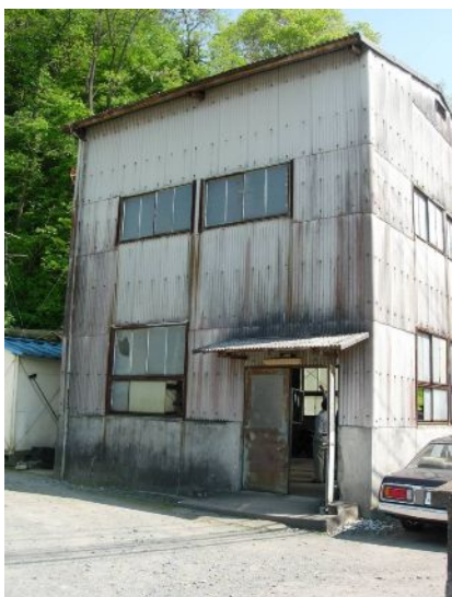
高城川揚水機場建屋は、施設の劣化状況が著しく機能回復が必要となっている。
