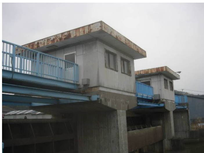
高城川防潮樋門操作室は、施設の劣化状況が著しく、機能回復が必要となっている。
