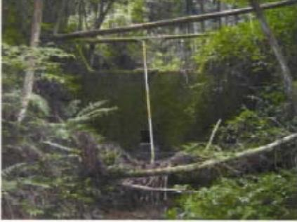
⑥ 治山施設上流の堆積状況(第2号谷止工 昭和44年度施工)
