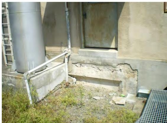
排水機場建屋の老朽化によるひび割れがみられ施設全体が劣化している。
