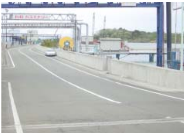
・施行済箇所現況写真
