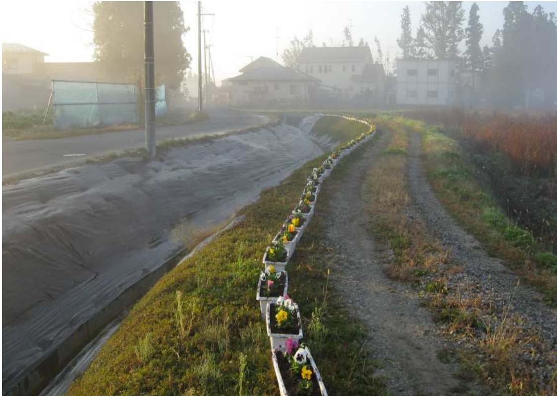
※集落の景観形成として、農道路肩にパンジーのプランターを設置(約80cm)
