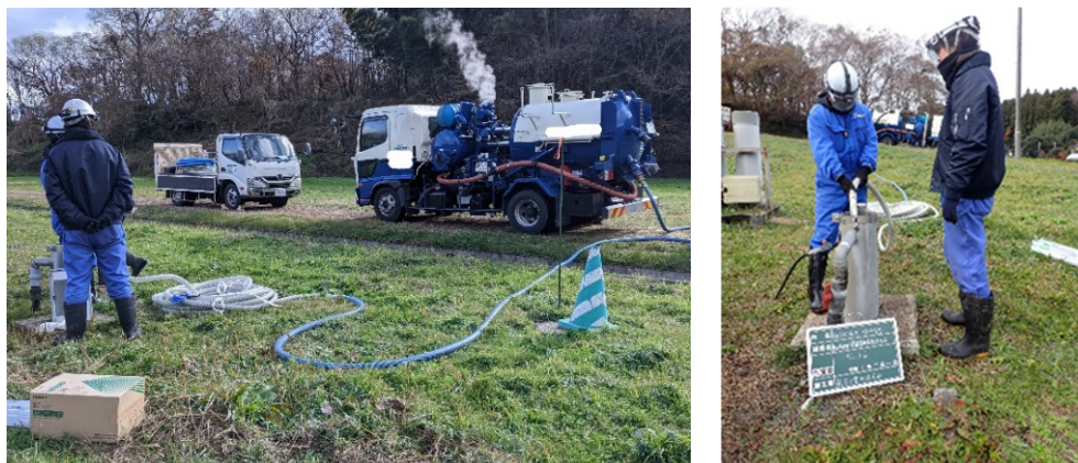
写真 1：井戸洗浄実施状況
