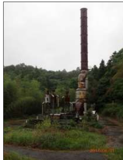
〈焼却施設の全景〉
