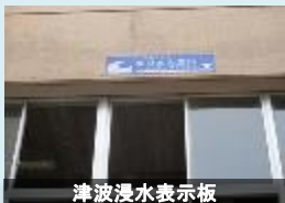
津波浸水表示板
