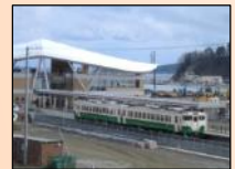
運行が再開された石巻線 (女川駅)
