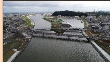
開通箇所の状況 (内海橋)
