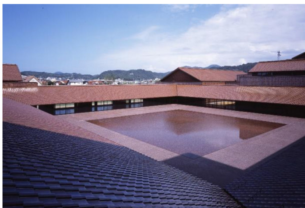
▲③島根県芸術文化センター（グラントワ）外観写真（中庭広場）
