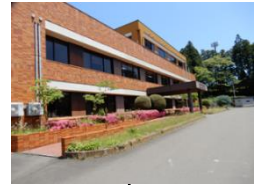
⑧多賀城分庁舎
