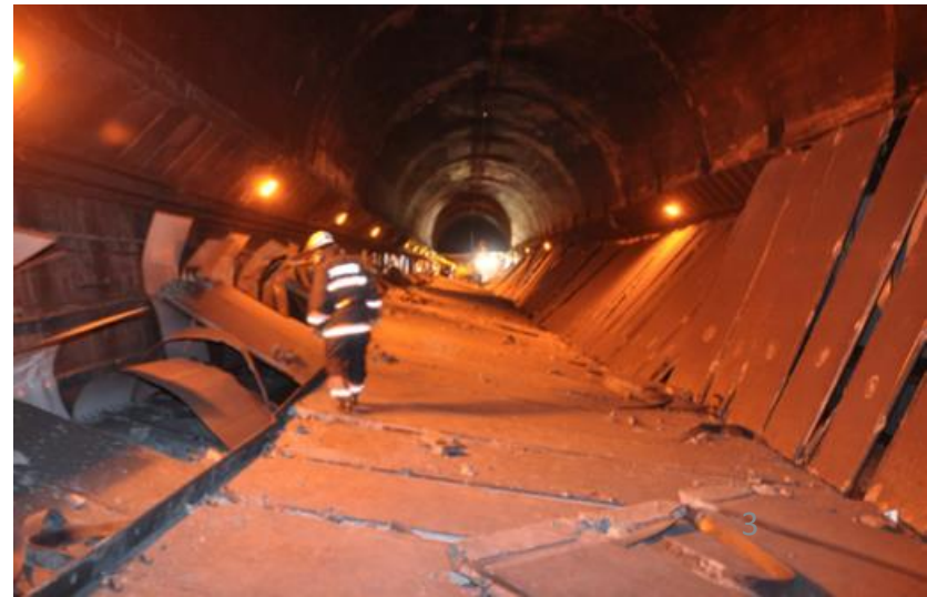
2012.12.2中央自動車道 笹子トンネル天井版崩落
