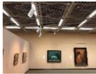
繊細な調光可能な照明機器が必要
