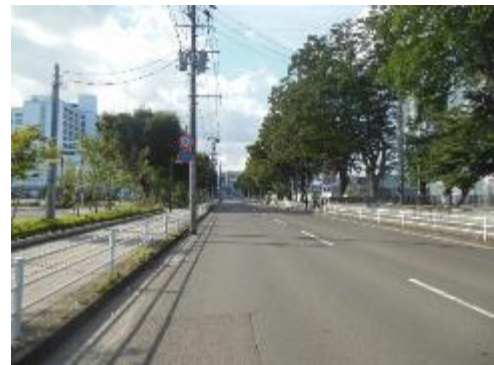
仙台医療センター跡地南側
