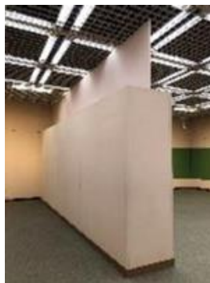
壁が低いため仕切り版で遮光性を確保している
