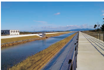
震災からの復旧・復興を図る北上運河
