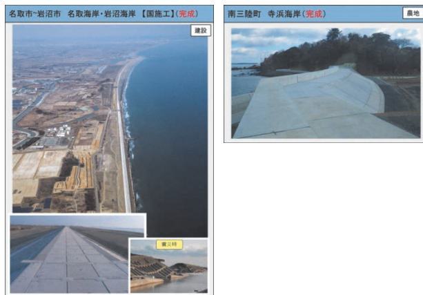
防潮堤災害復旧・復興の進捗状況 (平成28年9月現在)
