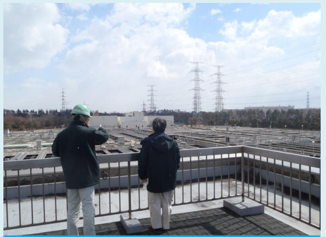
津波監視(屋上東側)
