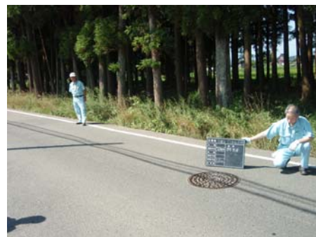
マンホール点検の様子
