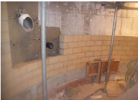
炉内耐火レンガ設置状況(8月頃)
