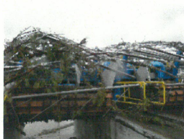
設備被災状況
