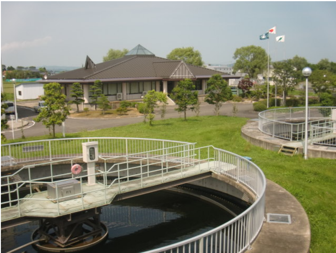
(鹿島台浄化センター)
